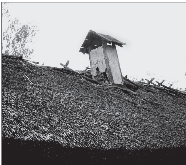
«Хворостяний» димар на реконструйованій хаті чинбаря у НІЕЗ «Переяслав». 2011 р. м. Переяслав-Хмельницький Київської обл. Фото Г. Івашків
