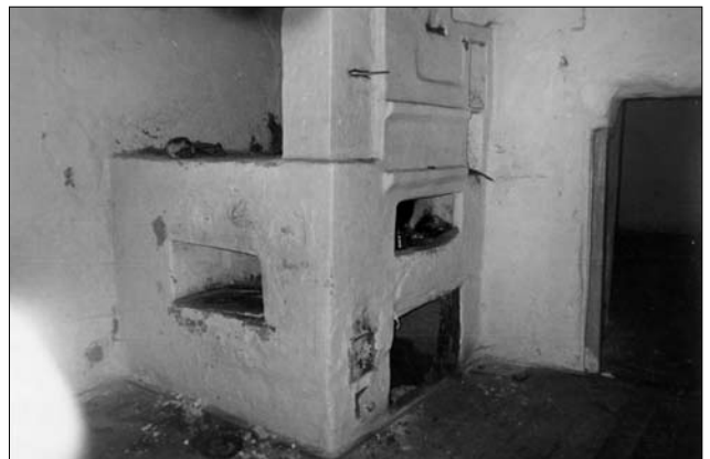
Зблокований кухонно-обігрівальний комплекс. Піч з підпиччям, груба з топочною камерою та металевою плитою. Село Рудня-Базарська, Народицький р-н, Житомирська обл. Світлина В. Сивака
