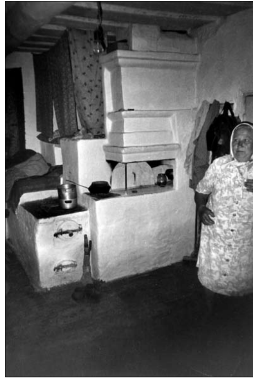
Піч з прибудованою топочною камерою, металевою плитою та невеликою лежанкою. Село Базар, Народицький р-н, Житомирська обл. Світлина В. Сивака
