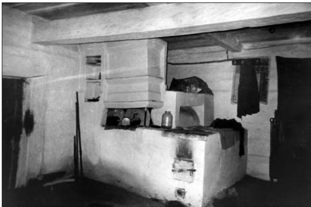
Піч з прибудованою топочною камерою та лежанкою без металевої плити. Село Будо-Вороб'ї, Малинський р-н, Житомирська обл. Світлина В. Сивака
