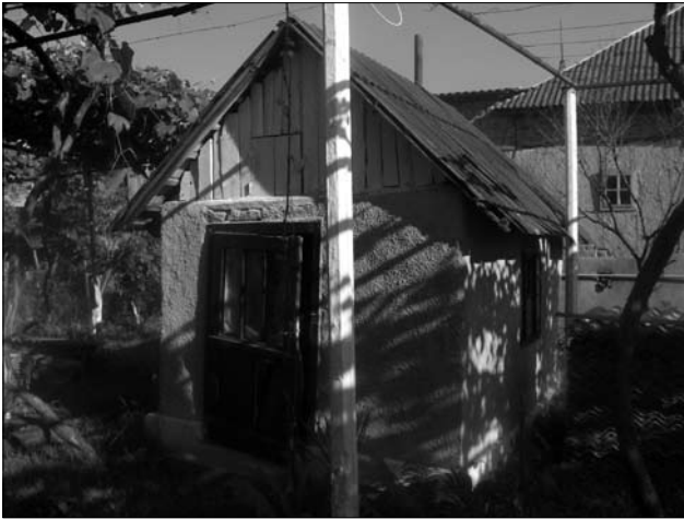
Іл. 15. Приміщення для печі, перероблене на літню кухню (фото: Кейс Б., Шаланки, 2010)
