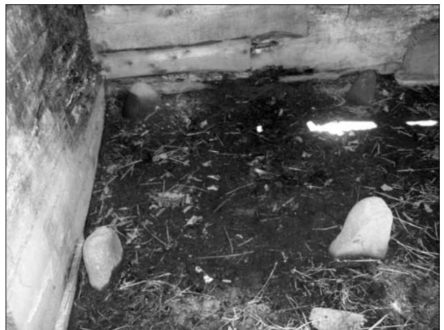
Іл. 7. Чотири камені — основа каркасу опіччя; с. Хмелівка Богородчанського р-ну Івано-Франківської обл.
