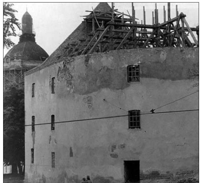
Порохова башта, пам'ятка архітектури XVI ст. Влаштування дерев'яних конструкцій даху. Фото середини 1950-х рр. За: https://www.lvivcenter.org/uk/uid/picture/?pictureid=8062
