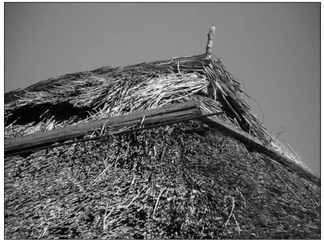
Іл. 10. Закріплення «кіски» до гребеня даху «шпилькою»; с. Долиняни
