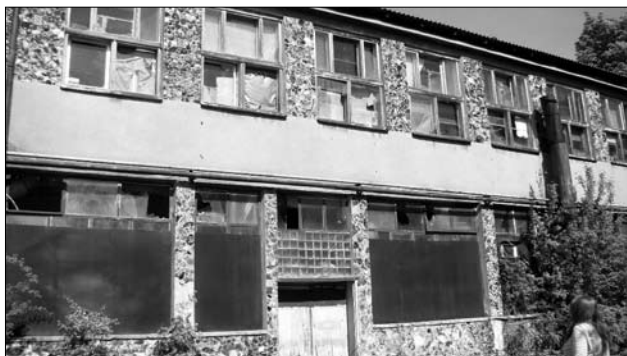
Іл. 33; 34. Приміщення ЛЕКСФ. 2019 р.
