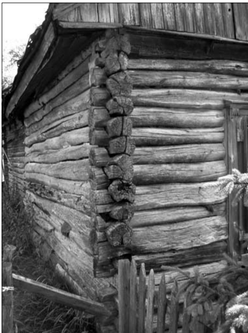
Іл. 1. Фрагмент зрубу хати, складеної з вільхового дерева; с. Пилипча Ріпкинського р-ну Чернігівської обл.
