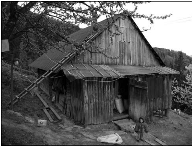
Іл. 6. Полянський двір: сіни + «хатинка» + стайня; всі входи до приміщень — на поздовжній осі; початок ХХ ст. Верхня Рожанка Сколівського р-ну Львівської обл. (фото І. Бойка, 2009)
