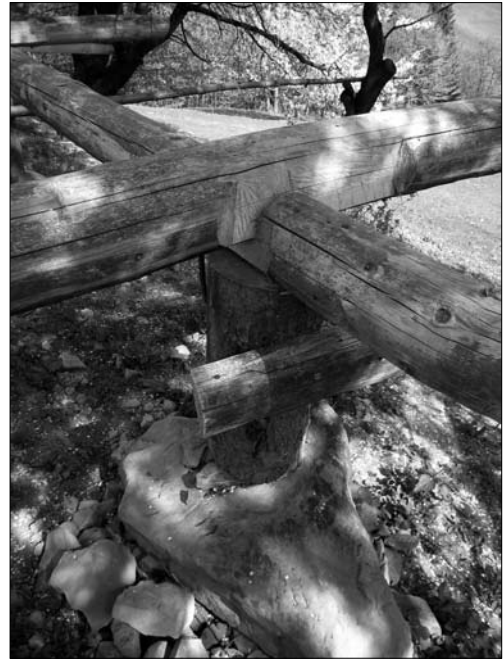
Іл. 12. «Ковбиця» під підвалинами новобудови, с. Верхня Рожанка Сколівського р-ну Львівської обл. (фото І. Бойка, 2009)
