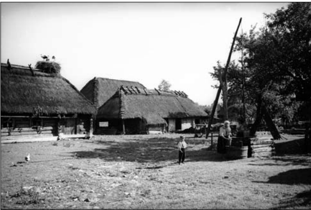
Іл. 2. Плоске покриття даху (покриття плескачками); с. Яблунька Богородчанського р-ну Івано-Франківської обл. Фото першої половини ХХ ст.
