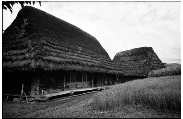
Іл. 3. Комбіноване покриття даху (головачками та внатрус); с. Опорець Сколівського р-ну Львівської обл. Фото першої половини ХХ ст.
