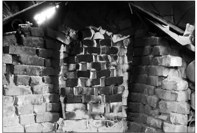
Іл. 5. Цегляна стінка з проміжками, яка розділяє пригребіщю і випалювальну камеру. В камері горить вогонь і проходить процес випалу, с. Олешня, Ріпкинський р-н, Чернігівська обл. 2017 р. Скріншот В. Боровика. Архів МАНКУП ДНЦЗКСТК
