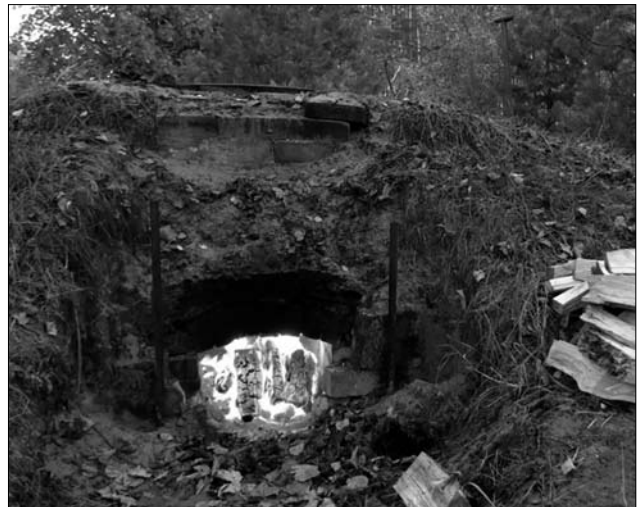
Іл. 13. Однокамерне, дводільне горно, власність Терезе Янкаускайте, Пелекішке, Алітуський повіт, Литва. 2015 р. Фото Міхала Матушика
