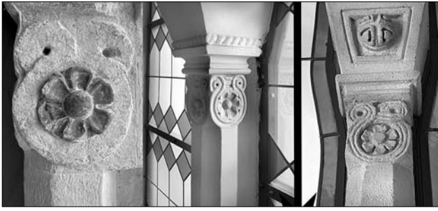
Іл. 5. Капітель міжвіконного стовпчика (зліва направо) у каплиці Дому інвалідів у Львові, в церкві Густава Адольфа у Відні та церкві на цвинтарі Мацляйнсдорф у Відні. Світлина авторів, 2024 р.
