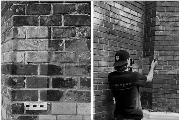
Іл. 3а. Виконаний реставраторами фрагмент очищення цегляної кладки каплиці з допомогою лазерної системи «Lumipeха». Світлини авторів, 2024 р.
