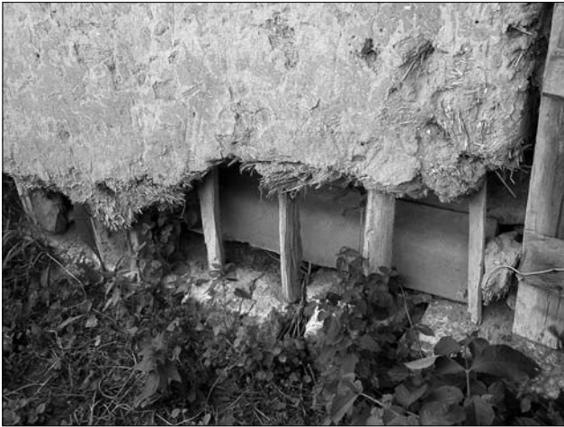
Іл. 2. Каркасно-валькована («кільована») стіна, с. Одаї Тисменицького р-ну Івано-Франківської обл.)
