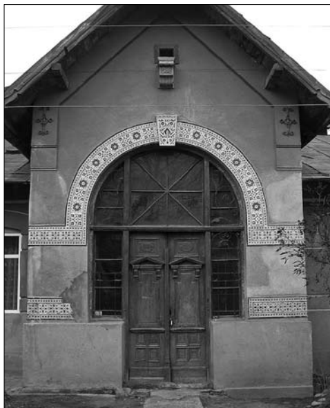
Іл. 4. Вхід до приміщення колишньої гончарної школи. Фото Я. Проціва. 2023 р.
