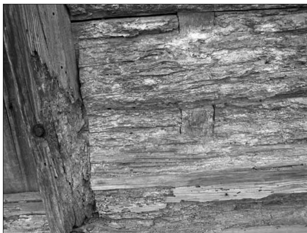
Іл. 4. З'єднання тиблем трьох суміжних вінців (с. Завадівка Корсунь-Шевченківського р-ну Черкаської обл.)
