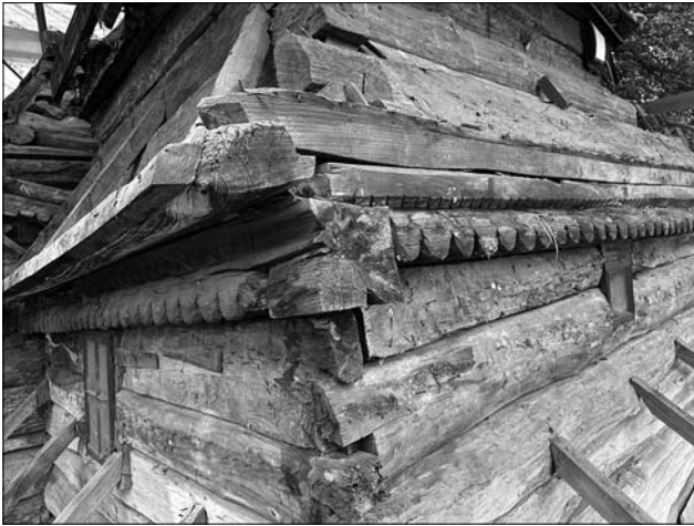
Іл. 19. З'єднання автентичних карнизів на південно-західному куті та маленьке віконце на півдні в заломі вівтаря, 2024. Світл. Я. Пащака
