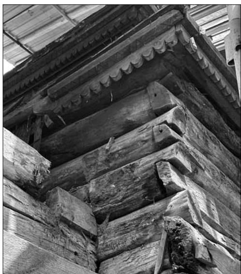
Іл. 10. Карниз набірний із дощок. Північно-східний кут нави, 2024. Світл. Я. Пащака
