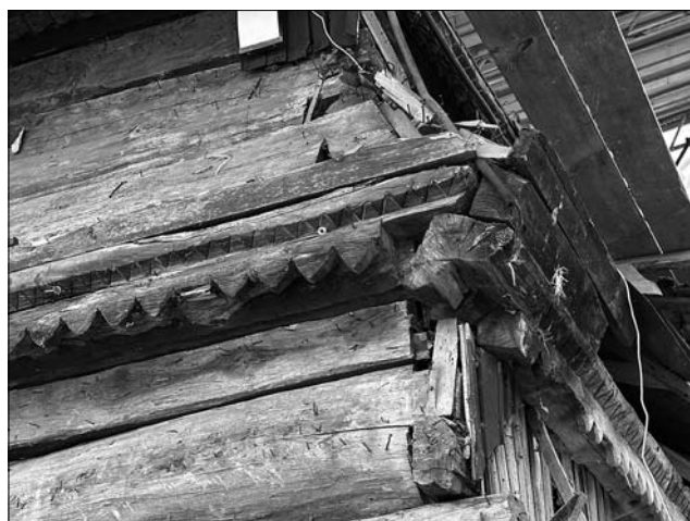
Іл. 15. З'єднання автентичних карнизів на вуглах. Південно-східний кут вітваря, 2024. Світл. Я. Пащака
