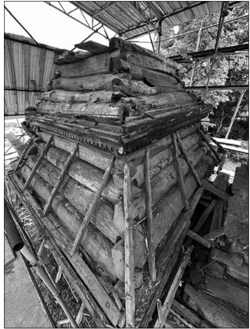
Іл. 17. Вирівнювання площин стін, заломів, нави за допомогою коротких кроків, 2024. Світл. Я. Пащака
