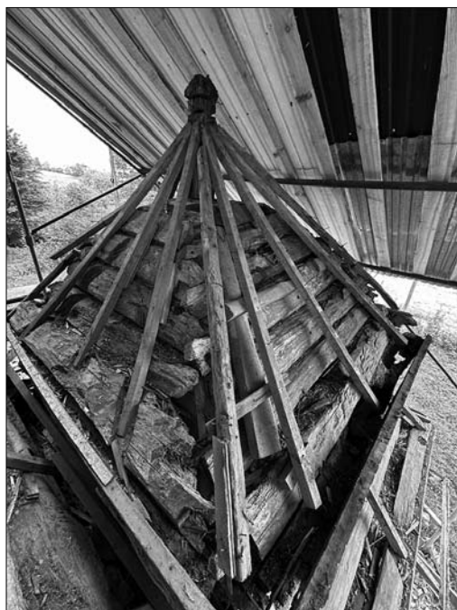
Іл. 16. «Реставрація» верха церкви шляхом створення над ним «нового верха» із крокв, 2024. Світл. Я. Пащака
