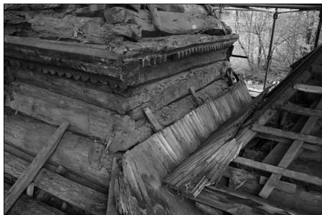
Іл. 12. Кіш між навою і бабинцем, 2024. Світл. Я. Пащака верхи виконані з м'яких листяних порід. Верх бабинця під впливом надмірного зволоження, пошкодження жуками-деревоточцями, невчасними та не-
