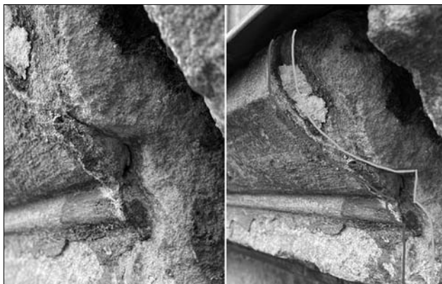
Іл. 18. Вапняковий карниз, що завершував третій поверх, під тиньком пізнішого профілювання. Світлина М. Козажевського, опубл. [18, с. 29]
