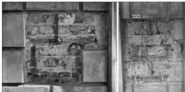
Іл. 20. Прориті канавки в цегляному муруванні другого поверху для рустування, які на 7 см зміщені щодо сучасного рустування. Світлина В. Карпіва та І. Змієвської
