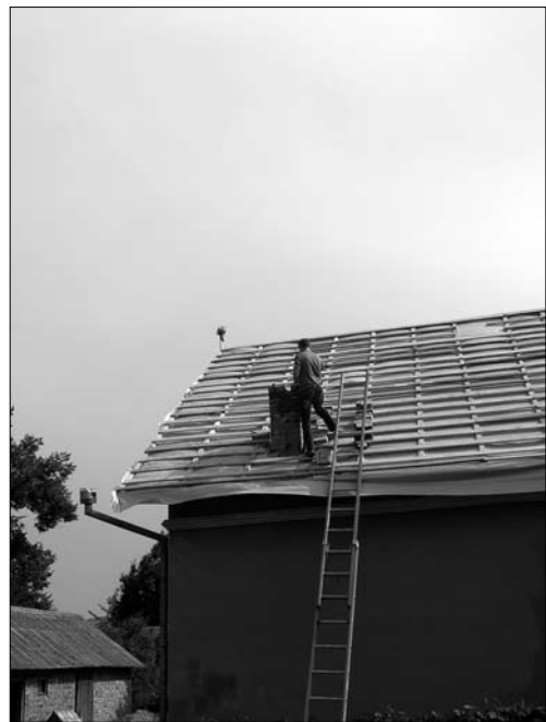
Іл. 3. Встановлення будівельного деревця, с. Добровляни Тисменецького р-ну Івано-Франківської обл.
